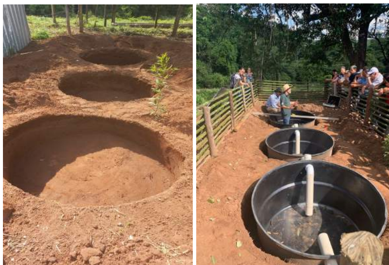
Figura 4 – Instalação da fossa séptica biodigestora.
